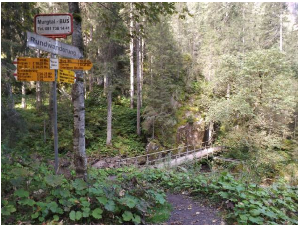
Abb. 6: Startpunkt der Rundtour über die Holzbrücke in den Gsponwald hoch zur Mürtschenalp.
