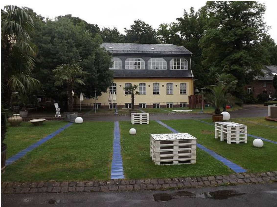
Abb. 14: Das Fabrikgebäude in dem heute Verwaltung und Museum untergebracht sind
