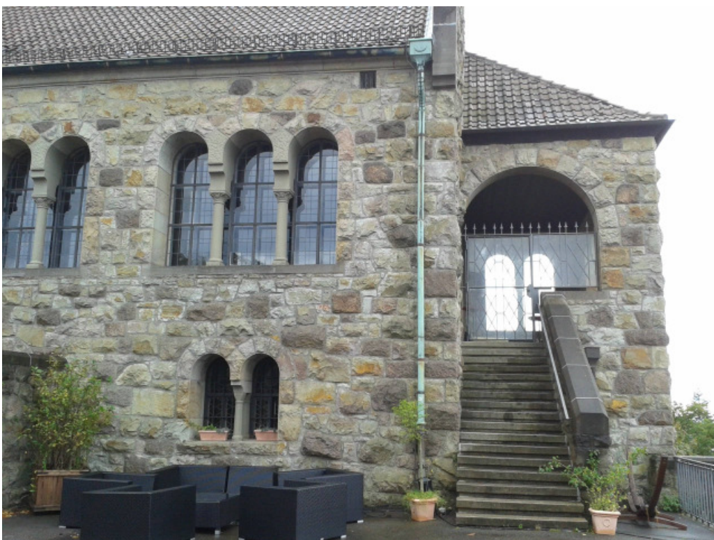
Abb. 3: Gebäudemauer aus Porphyrgestein
