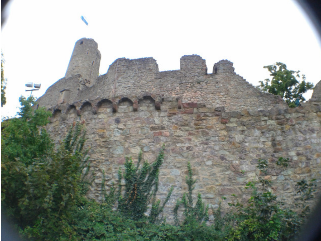
Abb. 5: Burganlage Windeck mit Mauern aus Porphyrgestein
