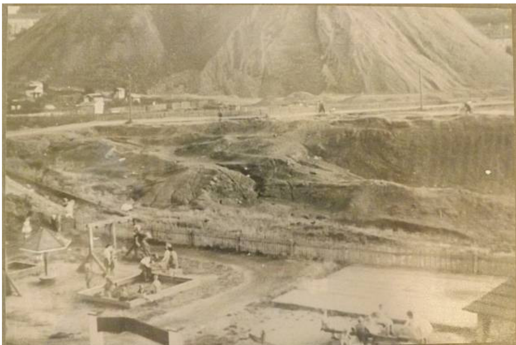
Halde 65 und Schlammteich in Oberschlema
