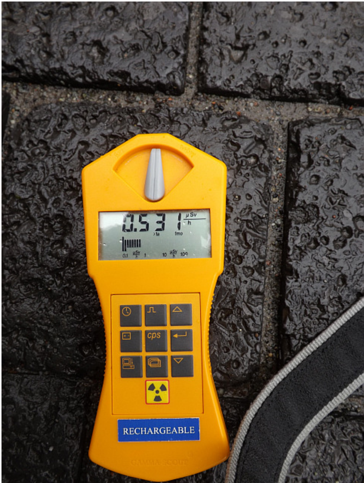
Abb. 2: Messung der Radioaktivität des Pflasters aus Schlackensteinen bei N54 18.559 E13 05.141 , die Anzeige ist in [\mu\text{Sv/h}] .
