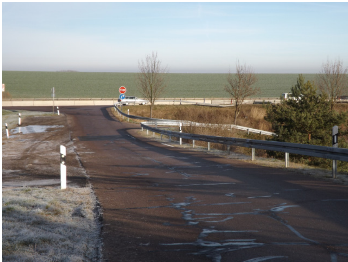
Abb. 8: Zugang für Straßendienste zur A4 neben der Brücke auf der Elgendorfer Strasse
