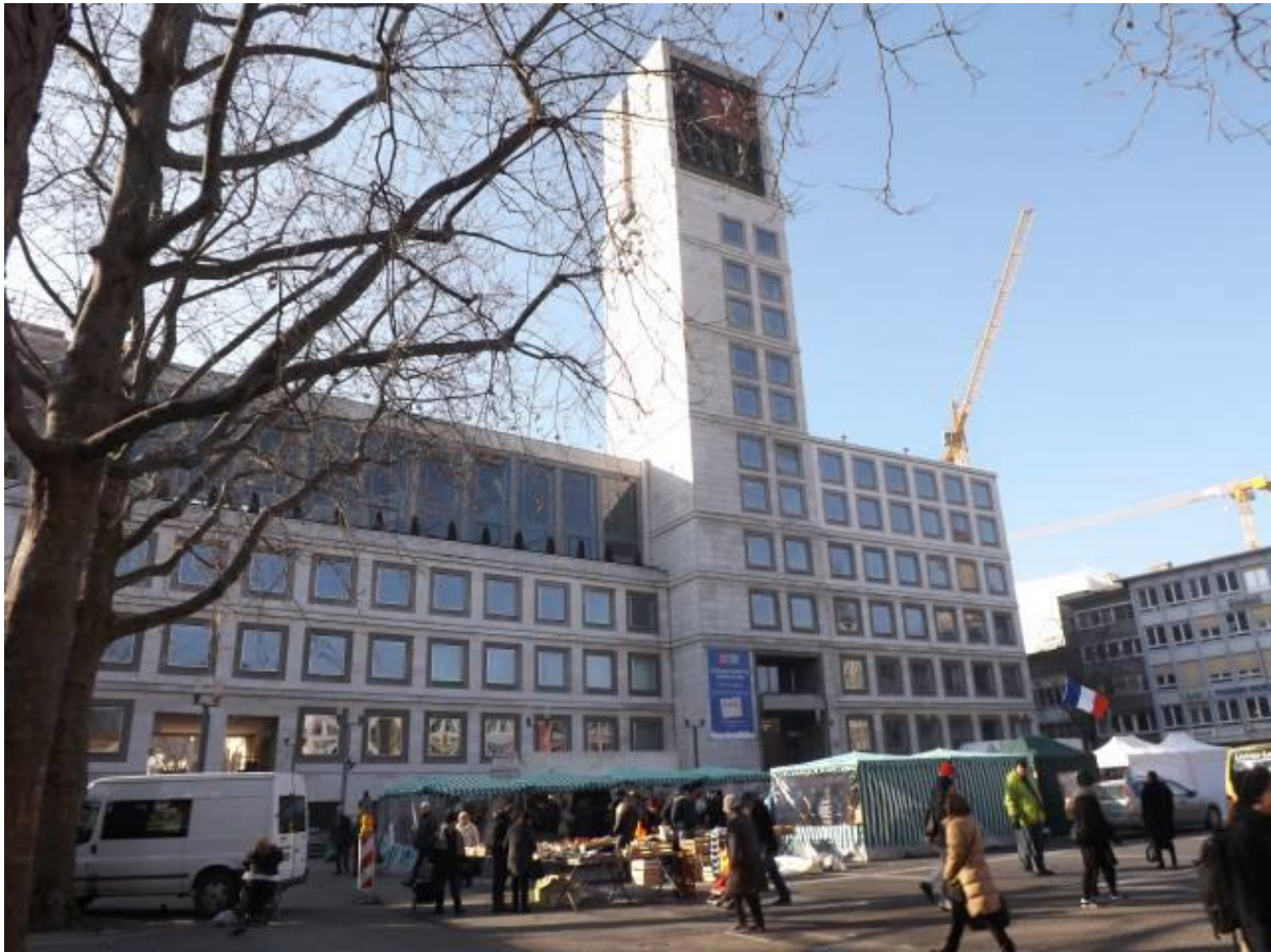
Abb. 4: Kein guter Platz sich vor Feinstaub zu schützen: das Rathaus in Stuttgart
